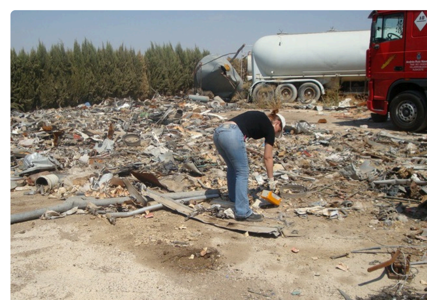
Trabajos de segregación UTPR.
