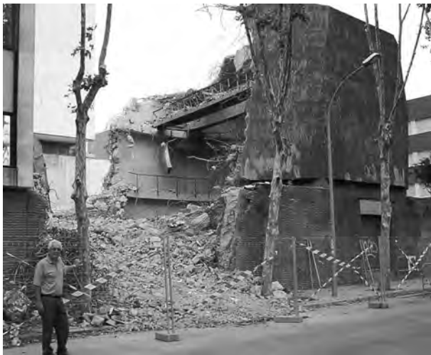
Figura 3: Desmantelamiento del reactor ARGOS.
