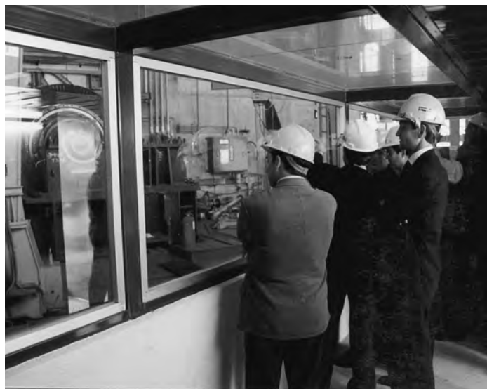
Foto 2. Desde el mirador de la nave del reactor podía observarse la realización de los trabajos de los equipos auxiliares al cajón del reactor. Para las zonas no accesibles se disponía de seguimiento mediante cámaras de TV.
